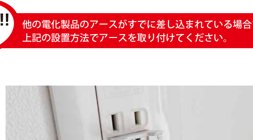
アース線を軽く引っ張り、線が抜けなにか念のために確認しましょう。
